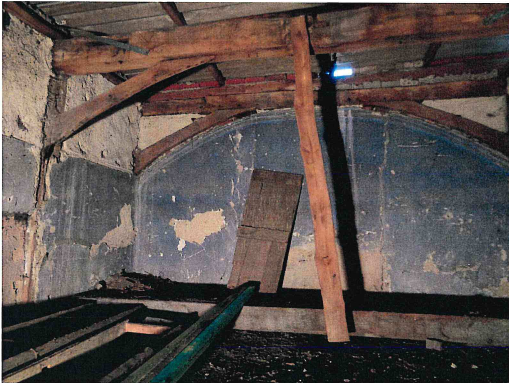
Synagogengebäude Steinstraße Telgte. Blick in den Luftraum des Synagogenraums zur östlichen Stirnwand: Die Konstruktion der gewölbten Decke ist noch teilweise erhalten, ebenso die (vermauerte) Thoranische in der Mitte der Stirnwand sowie die blaue Ausmalung des Raums. (Zustand Januar 2019).
