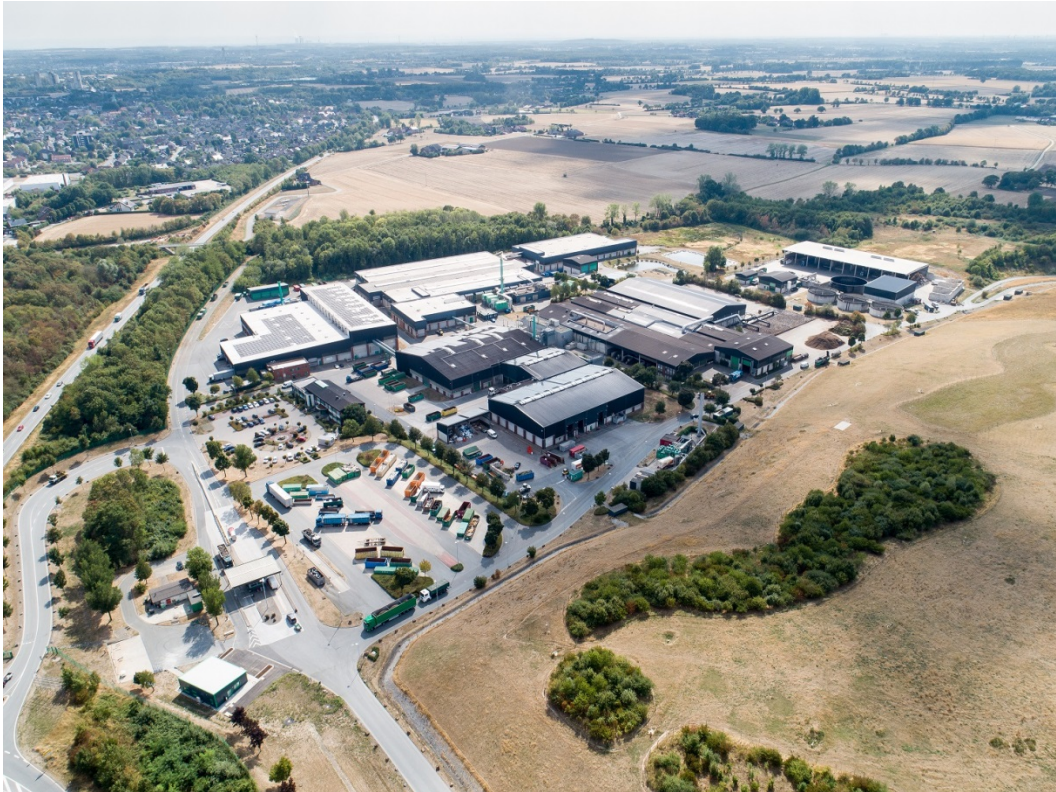
Abfallwirtschaftsgesellschaft des Kreises Warendorf mbH – Entsorgungszentrum in Ennigerloh
