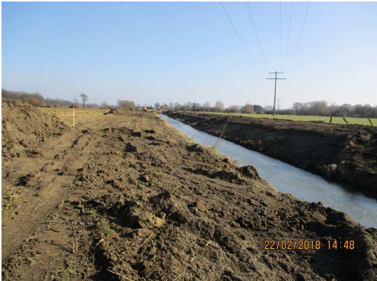
Bild 1: Blick gegen Fließrichtung westlicher Bauabschnitt
