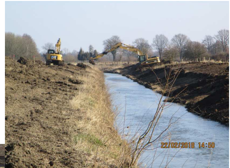
Bild 3: Blickrichtung gegen Fließrichtung, östlicher Bauabschnitt
