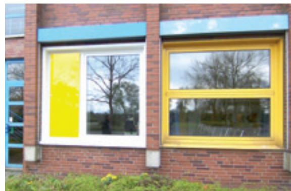
Neues Fenster und altes Fenster
