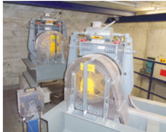
neuer Aufzugsantrieb
