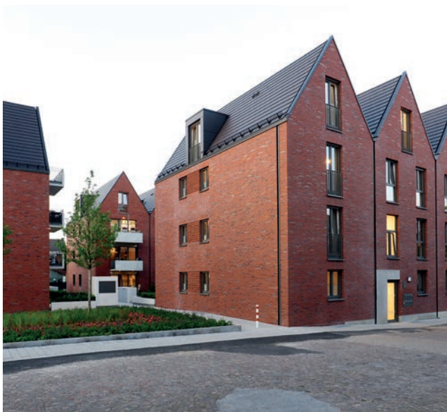
Neubau geförderter Mehrfamilienhäuser in Ennigerloh (Bauprojekt der Städtischen Baugesellschaft Ennigerloh)
