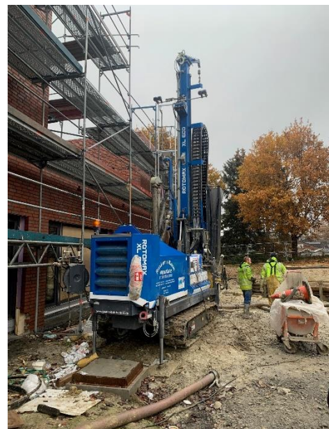
Abbildung 14 - Durchführung von Tiefenbohrungen für die geothermische Nutzung am Jobcenter Beckum
