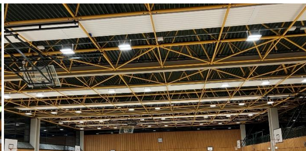
Abbildung 18 - Sporthalle Berufskolleg Ahlen Beleuchtung (LED) nach Umrüstung
