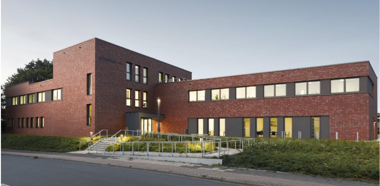
Abbildung 13 - Neubau Jobcenter Beckum 2024
