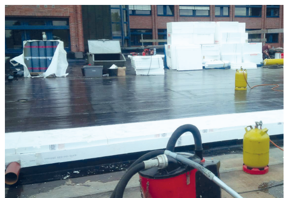
Neuaufbau "Warm-Dach"
