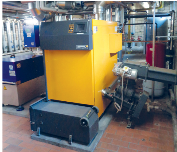
Pelletkessel (oben) und Blockheizkraftwerk (unten) am Berufskolleg Ahlen
