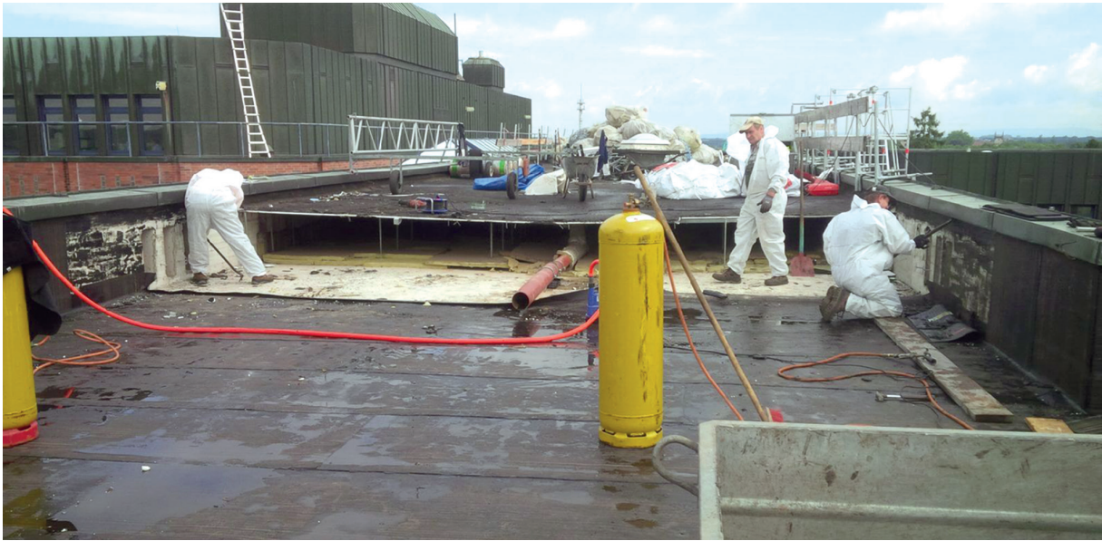
Rückbau "belüftetes Kalt-Dach"
