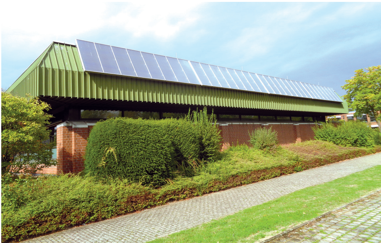
Thermische Solaranlage am Berufskolleg Ahlen
