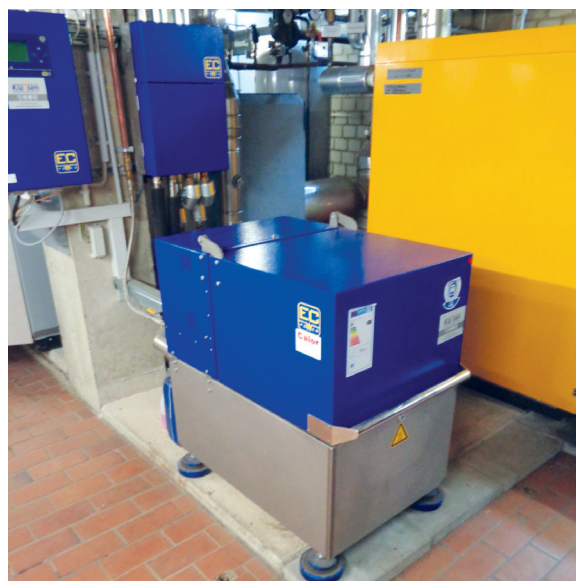
Pelletkessel (oben) und Blockheizkraftwerk (unten) am Berufskolleg Ahlen
