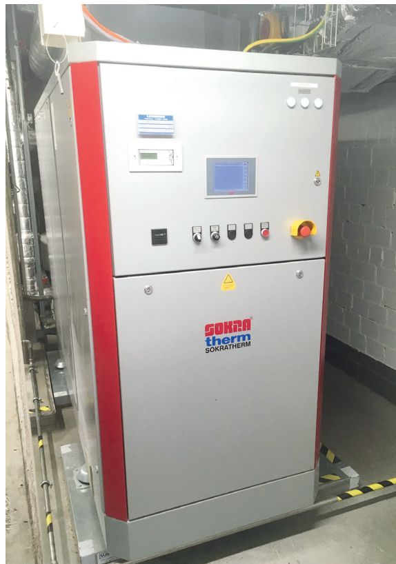
Blockheizkraftwerk im Kreishaus
