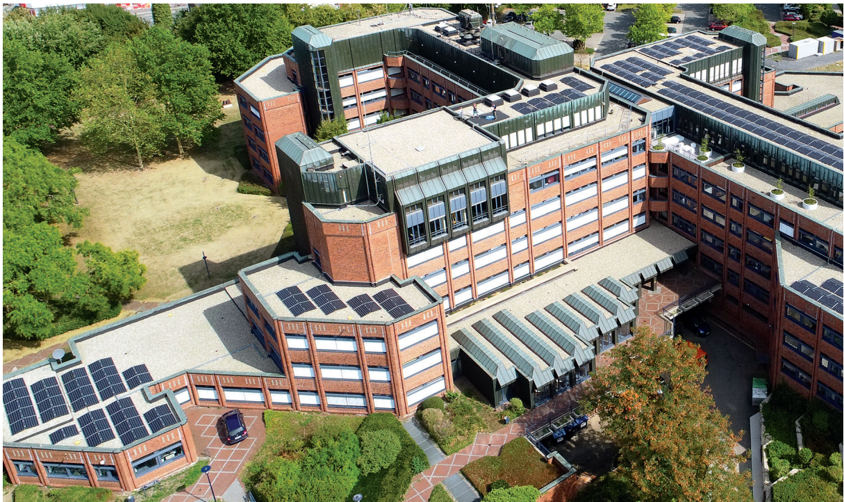
PV-Anlage auf dem Kreishausdach
