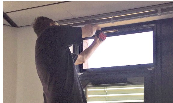
Beschlagteile werden erneuert
