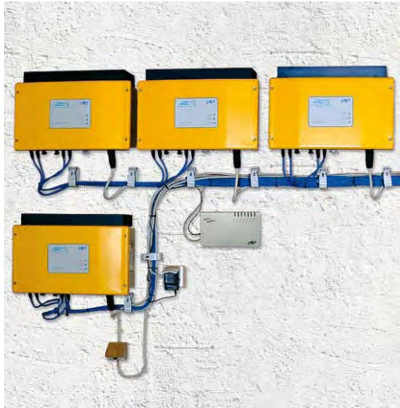
Die Installation der Wechselrichter (wenn möglich staubgeschützt und nicht direkt der Sonne ausgesetzt) sollte rechtzeitig mit dem Installationsbetrieb besprochen werden.
