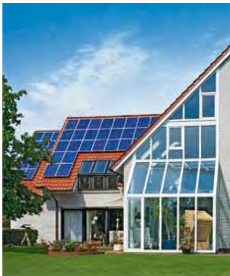
Aufdachanlage mit polykristallinen Modulen. Fotos: Schüco International KG
