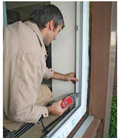
Mehrere Hundert Euro pro Heizperiode verschwinden durch undichte Fensterrahmen und veraltete Verglasungen. Beim Austausch der alten Fenster gegen neue Energiesparfenster sollte auf eine fachgerechte Montage durch den Fensterfachbetrieb geachtet werden.
