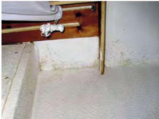
Schimmelbildung bedingt durch Feuchteschäden am Mauerwerk.
