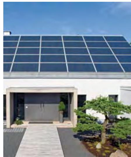
Indachanlage mit kristallinen PV-Großmodulen der Premium-Linie
