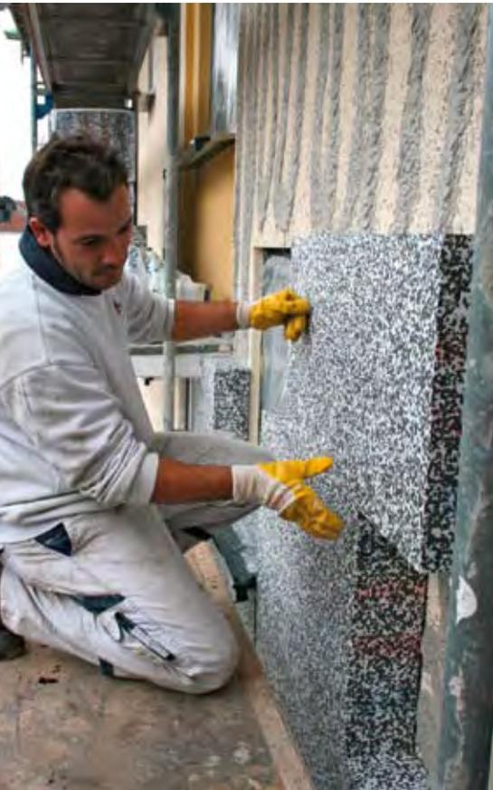
Energieeinsparung durch Fassadendämmung: Die Dalmatinerplatte läßt sich auch bei hohen Temperaturen sicher und rationell verarbeiten. Ihre thermische Unempfindlichkeit sorgt für hohe Formstabilität.
