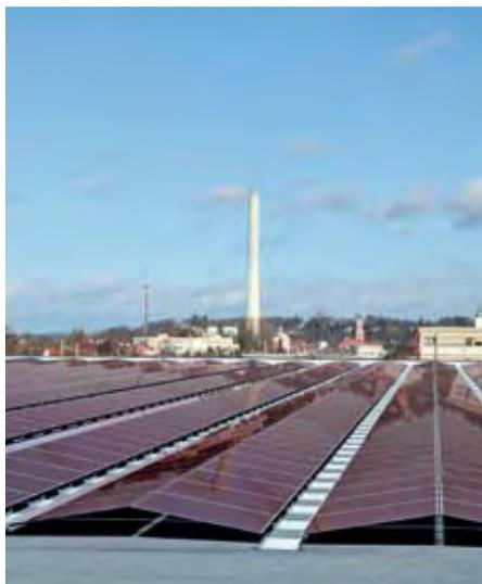
Flachdachanlage mit Dünnschichtmodulen
