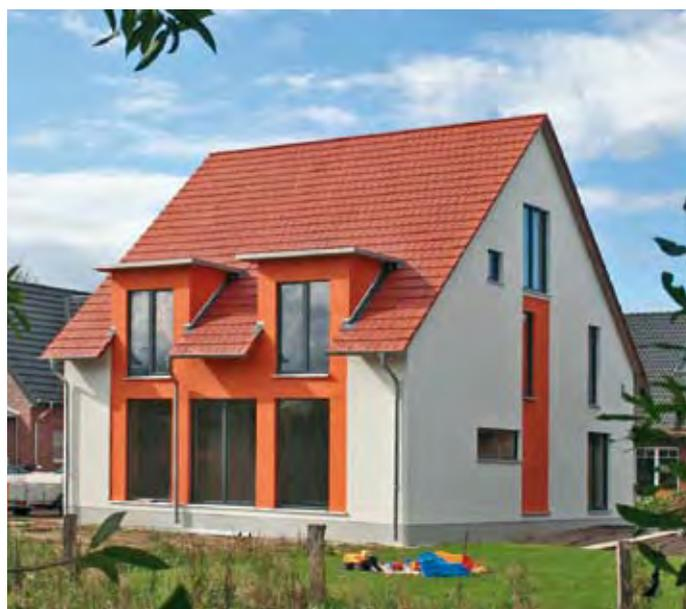
Freistehendes Einfamilienhaus in Münster Roxel. Holzrahmenkonstruktion mit Zellulosedämmung, Weichfaserplatten und Silikonharzputz.
