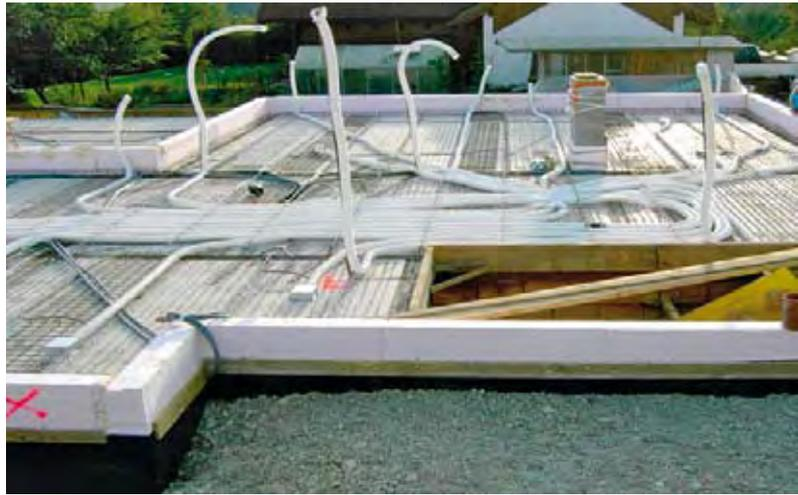
Hier wird es richtig gemacht und die Chance zur Installation einer Lüftungsanlage genutzt. Die Zu- und Abluftleitungen für die Lüftung sollten in keinem Neubau fehlen.
