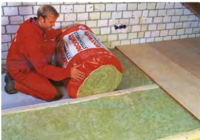
Dämmung der obersten Geschossdecke. Hier sollten 25 cm und mehr an Dämmung aufgebracht werden.
