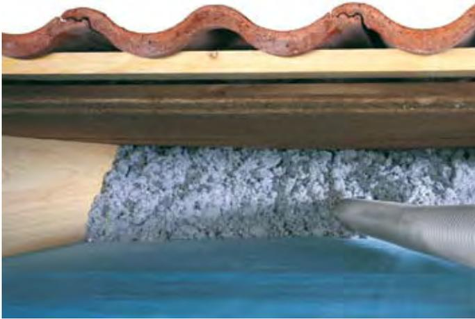
Schnell, passgenau und hochwirksam: Dachdämmung mit Einblaszellulose und Holzweichfaserplatte.
