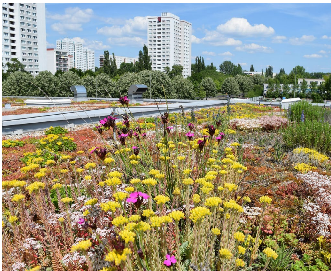
Abbildung 29: Dachbegrünung als Maßnahme (Foto: Bundesverband GebäudeGrün e. V.)
