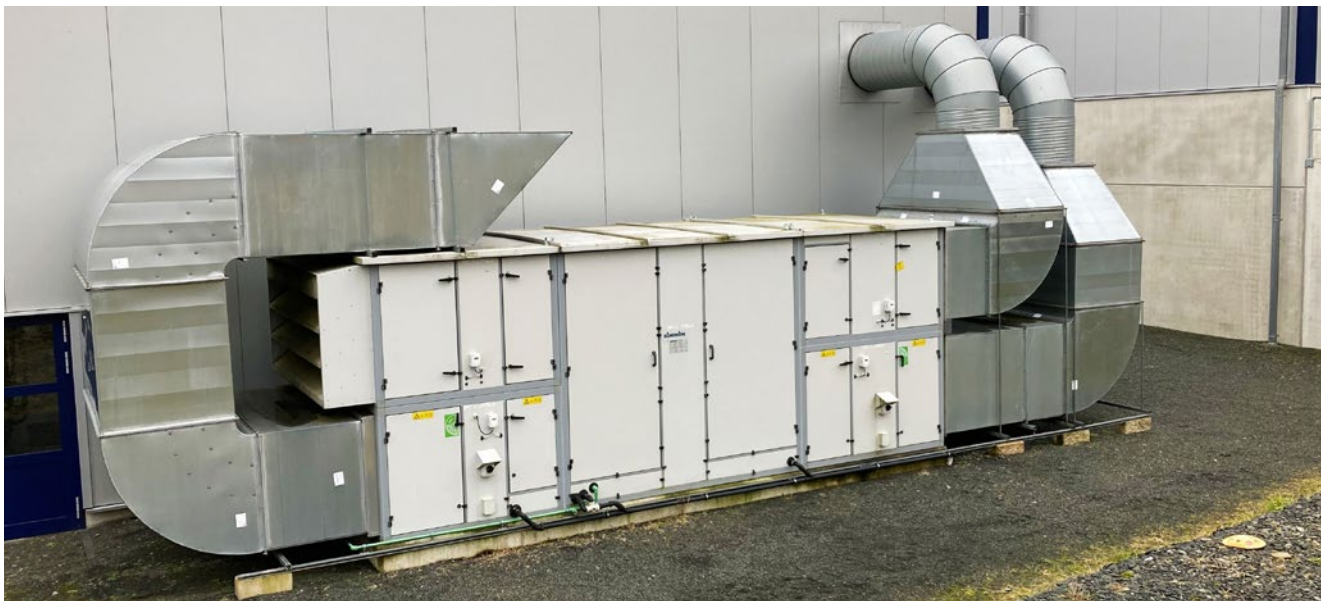
Abbildung 11: Adiabate Kühlanlage - eine klimafreundliche Alternative zu herkömmlichen Klimaanlage, da die Abwärme zur Kühlung genutzt wird. (Foto: Lüning, Kreis Soest)
