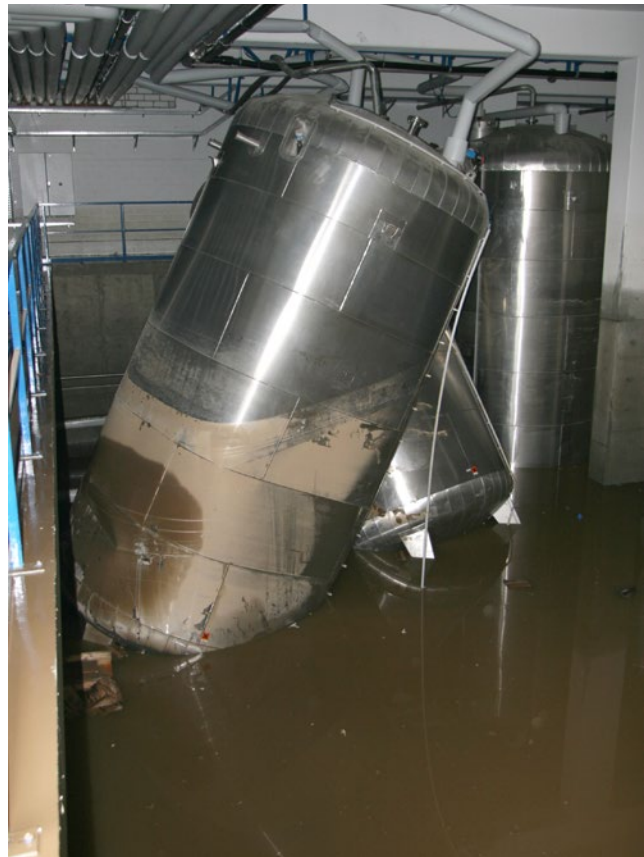
Abbildung 4: Aufschwimmen von Behältern durch ein Hochwasserereignis (Foto: fit GmbH Zittau)
