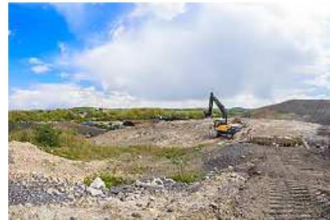
Zentraldeponie Hamm DK I
