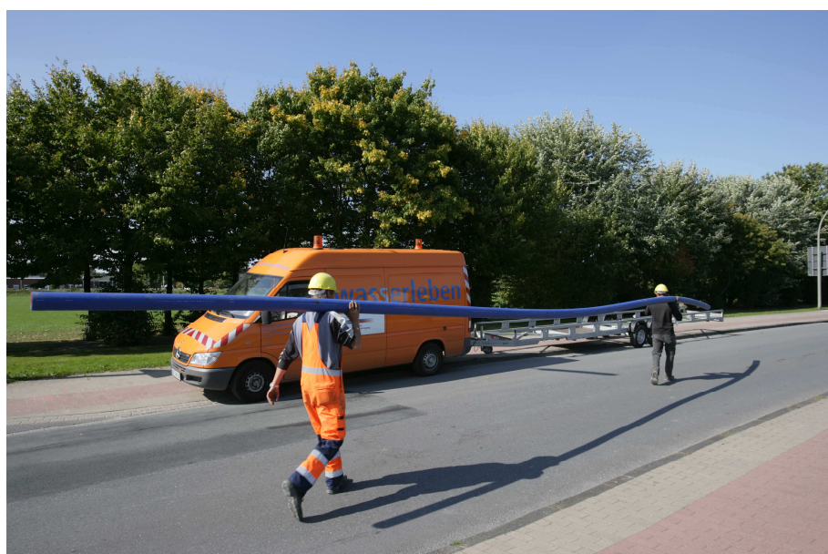
Bildquelle: Wasserversorgung Beckum GmbH: Rohrnetzarbeiten
