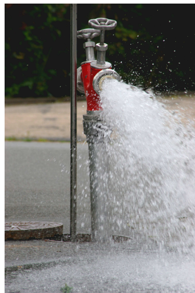
Bildquelle: Gemeindewerke Everswinkel GmbH: Standrohr z.B. für Spülmaßnahmen im Netz
