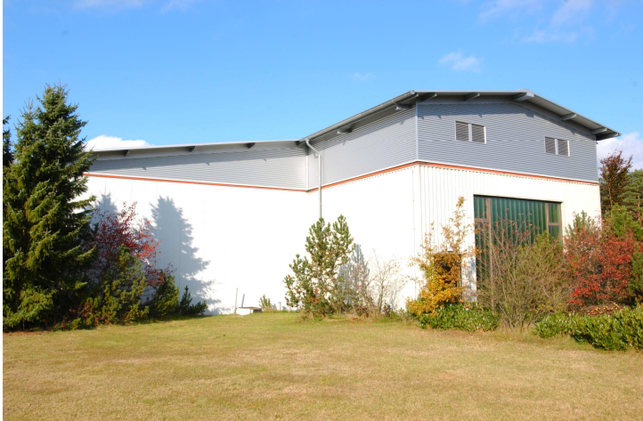
Bildquelle: Wasserbeschaffungsverband Sassenberg- Vermold-Warendorf: Gebäude des Reinwasserbehälters, Wasserwerk Füchtorf
